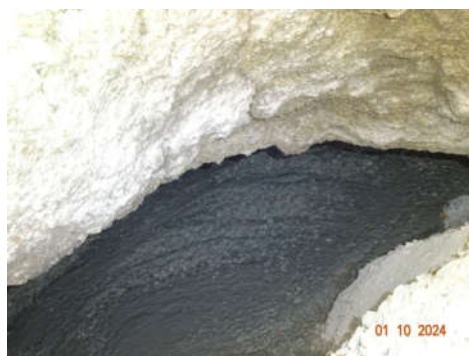
foto 10 - Getto di malta di cemento tipo magrone a saturazione
