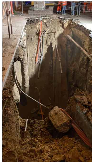
foto 6 - demolizione della pavimentazione stradale sospesa nel vuoto
