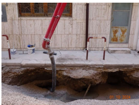
foto 9 - Getto di malta di cemento tipo magrone con l'ausilio di pompa
