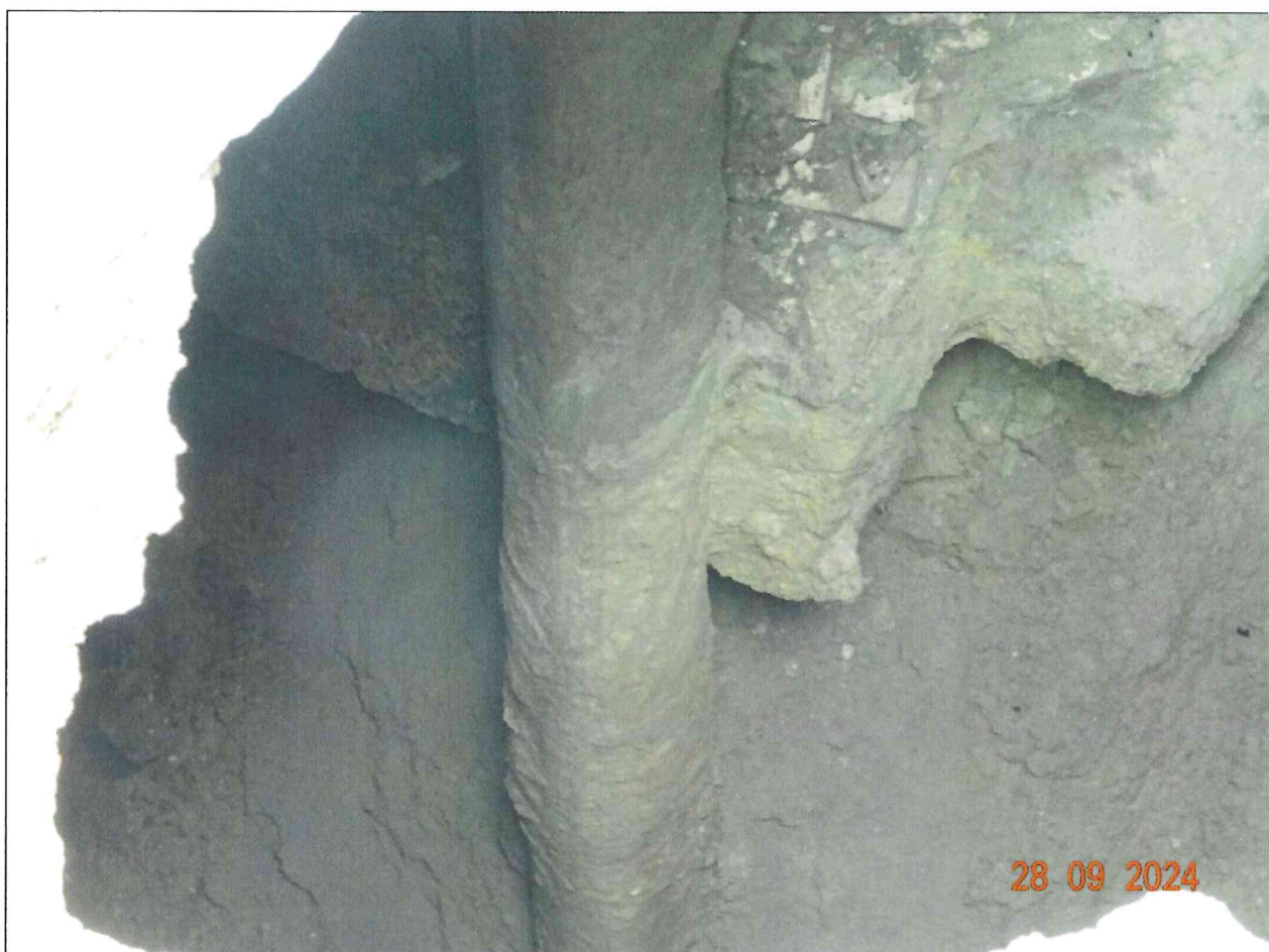
foto 3 - vuoto che si protende sotto i fabbricati con strutture fondali parzialmente a vista
