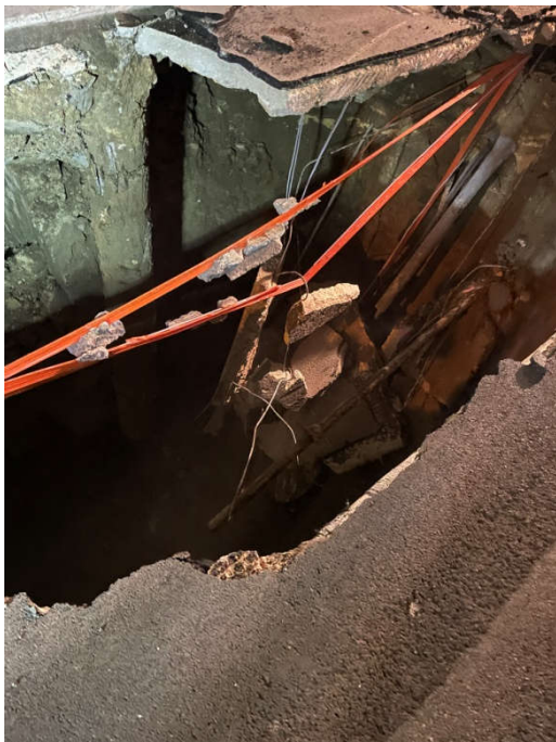
foto 5 - demolizione della pavimentazione stradale sospesa nel vuoto e sottostante solettone in c.a.
